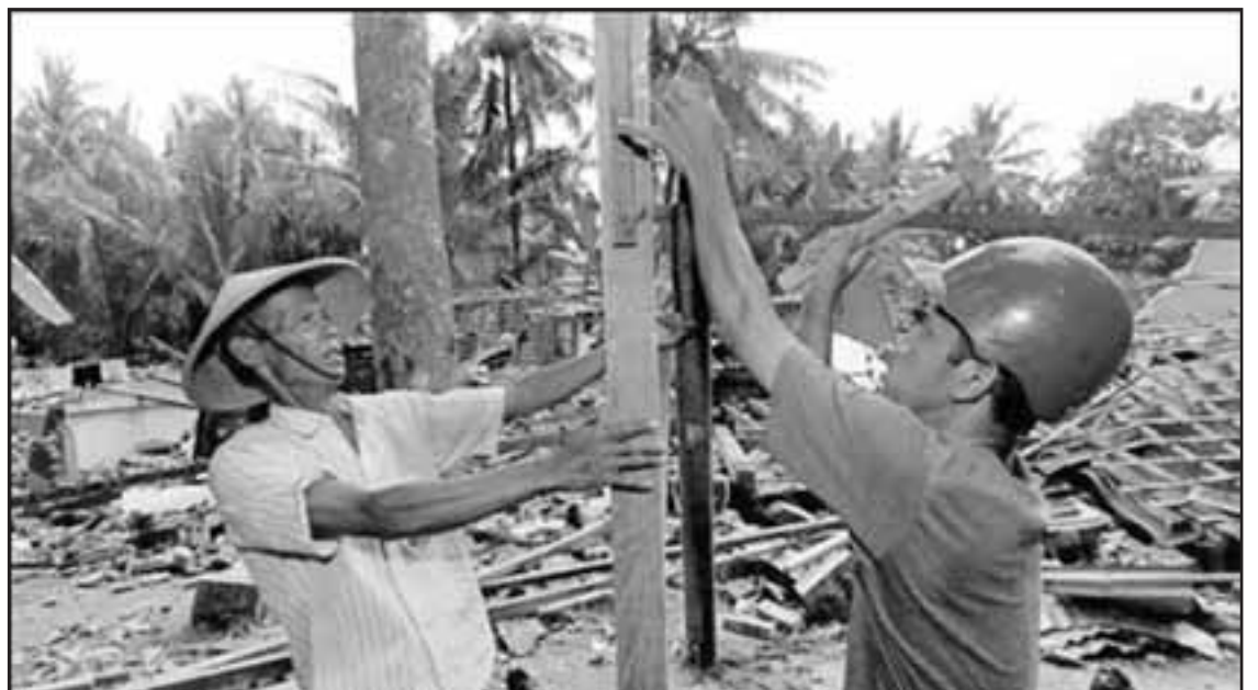
Habitantenan ta contruyendo un refugio temporal na bantul, despues cu e temblor a sacudi e ciudad.
